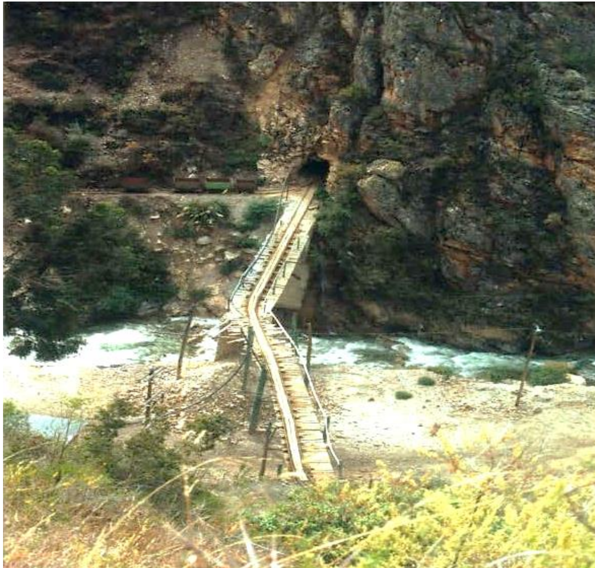
NIVEL 2700 TUNEL WILDER
